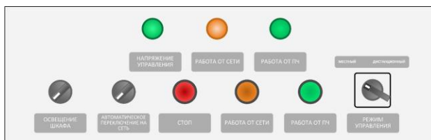
Рис. 6.8 - Панель управления системы автоматического байпаса
